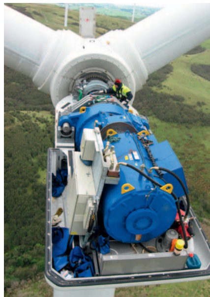
4 Arbeitsplatz in luftiger Höhe: Die Wartung und Reparatur von Windkraftanlagen ist aufwendig – umso wichtiger ist ein langer, störungsfreier Lauf aller Komponenten
